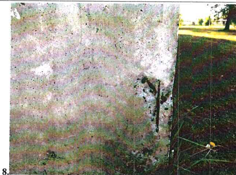
Betona aizsargkārtas bojātā vieta pamatu paneļos
