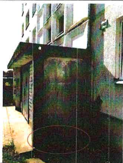
Sūnojums un betona apdrupums stiegrbetona sienīpā
