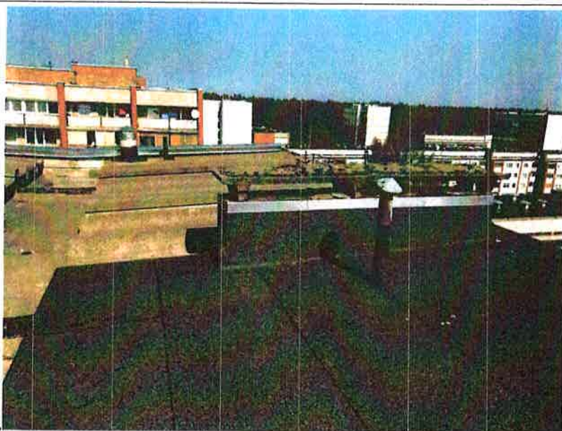
Siltinātā jumta daļa, segums - ruberoīds
