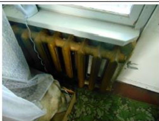
12.att. Ēkas dzīvokļos uzstādīti čuguna sildķermeņi.
