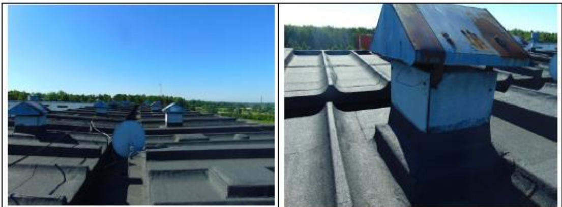
7.att. Ēkai uzstādīts plakana jumts, ar iekšējo lietus ūdens savākšanas un novadīšanas sistēmu. Jumta segums apmierinošā stāvoklī. Veicot ēkas atjaunošanu, nepieciešams pievērst uzmanību tam, vai nav nepieciešami lokāli jumta seguma remontdarbi, lai izvairītos no jaunā siltumizolācijas slāņa bojāšanās. Kā arī jāveic ventilācijas šahtu tehniskā apkope un tīrīšana.
