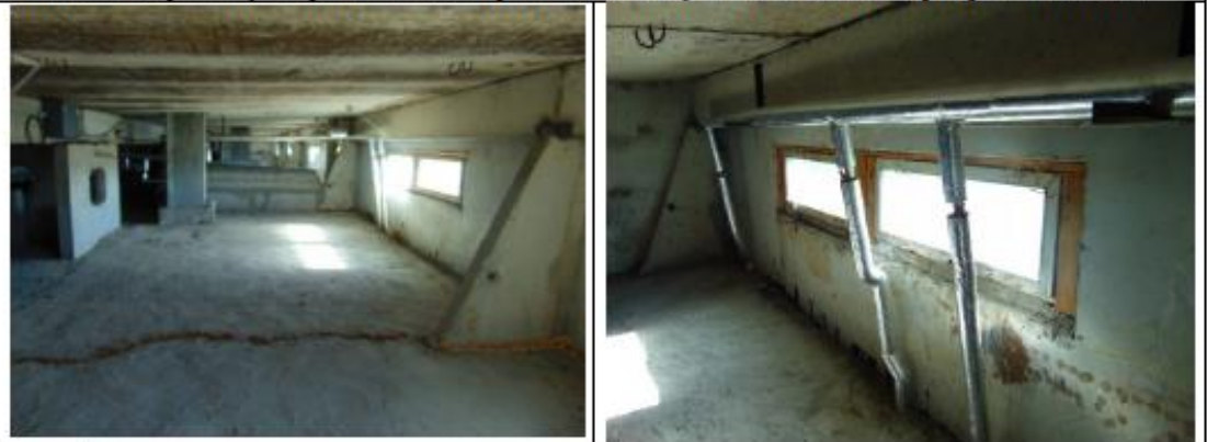
8.att. Ēkas tehnisko bēniņu grīdas un griestu pārsegums apmierinošā stāvoklī. Tehniskajos bēniņos esošo apkures cauruļvadu siltumizolācijas tehniskais stāvoklis ir apmierinošs.
