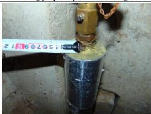
11.att. Cauruļvadu siltumizolācija pagraba telpās.
