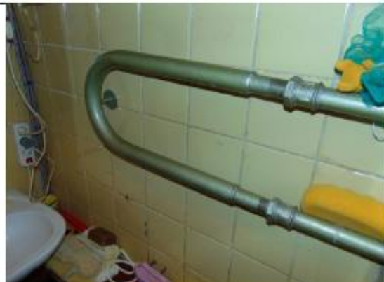
13.att. Ēkas dzīvokļu vannas istabās ierīkoti „dvielu žāvētāji”, kas pieslēgti pie karstā ūdens cirkulācijas loka.
