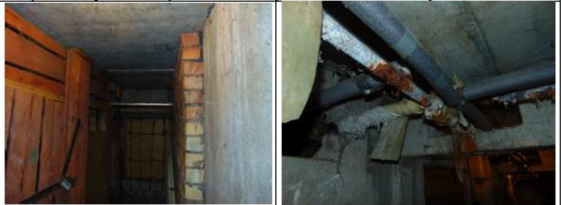
9.att. Ēkas pagraba telpās esošo karstā ūdens cauruļvadu siltumizolācijas tehniskais stāvoklis ir neapmierinošs, līdz ar to, jāveic to siltumizolācijas slāņa atjaunošana vai cauruļvadu nomaiņa pret rūpnieciski izolētiem cauruļvadiem. Veicot pagraba griestu siltināšanu, nepieciešams pievērst uzmanību saglabājušos koka šķūnīšu konstrukciju demontāžai, lai kvalitatīvi tiktu uzklāts jaunais siltumizolācijas slānis.
