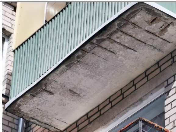
27.att. Bojāta balkonu nesošā plātne
