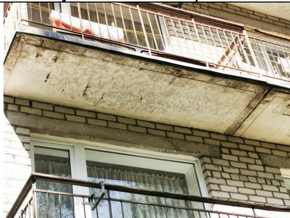
29.att. Bojāta balkonu nesošā plātne
