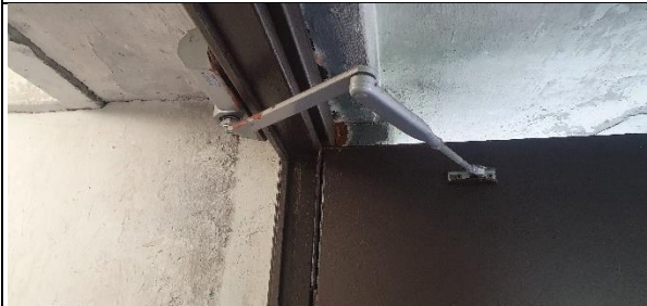
3.att. Ēkas kāpņu telpai nomainītas durvis pret metāla durvīm un tas ir aprīkotas ar aizvērēj mehānismu
