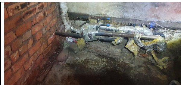
8.att. Pagrabā veikta daļēja karstā ūdens un apkures sistēmas cauruļvadu nomaiņa un siltināšana, taču atsevišķās vietas darbi nav veikti atbilstoši labākajai praksei.
