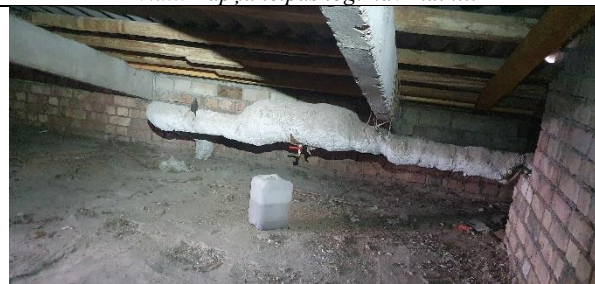
11.att. Bēniņos cauruļvadu nomaiņa un siltumizolācijas slāņa atjaunošana nav veikta.
