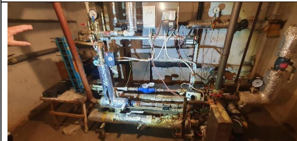
7. Ēkā uzstādīts neatkarīgā pieslēguma tipa siltummezgls, kurā tiek uzsildīts ēkas apkures loka siltumnesējs, kā arī tiek sagatavots karstais ūdens.
