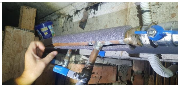
8.att. Pagrabā veikta daļēja karstā ūdens un apkures sistēmas cauruļvadu nomaiņa un siltināšana, taču atsevišķās vietas darbi nav veikti atbilstoši labākajai praksei.
