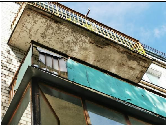
28.att. Bojāta balkonu nesošā plātne
