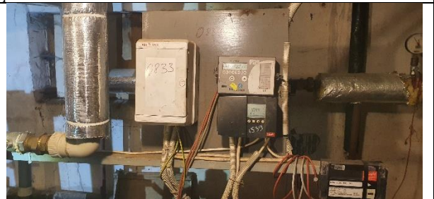
7. Ēkā uzstādīts neatkarīgā pieslēguma tipa siltummezgls, kurā tiek uzsildīts ēkas apkures loka siltumnesējs, kā arī tiek sagatavots karstais ūdens.
