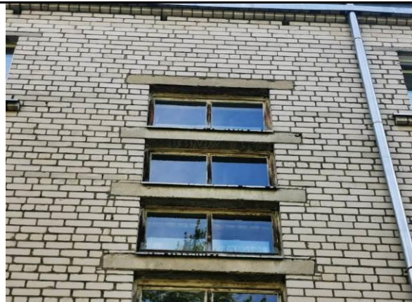
16.att. Logu aiļu dz/betona pārsedzes
