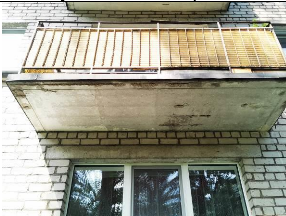
30.att. Bojāta balkonu nesošā plātne
