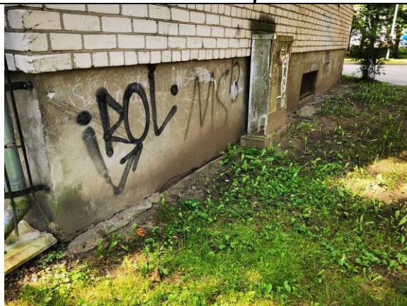
12.att. Nosēdusies betona apmale
