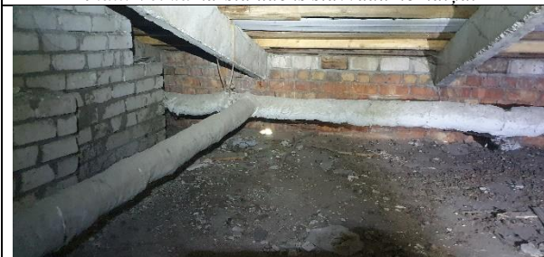
11.att. Bēniņos cauruļvadu nomaiņa un siltumizolācijas slāņa atjaunošana nav veikta.
