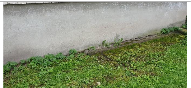
5.att. Nepieciešams veikt pamatu apmales remontu, lai nodrošinātu efektīvu lietuss ūdens novadīšanas sistēmas darbību un nepieļautu ūdens uzkrāšanos un mitruma iesūkšanos pamatos
