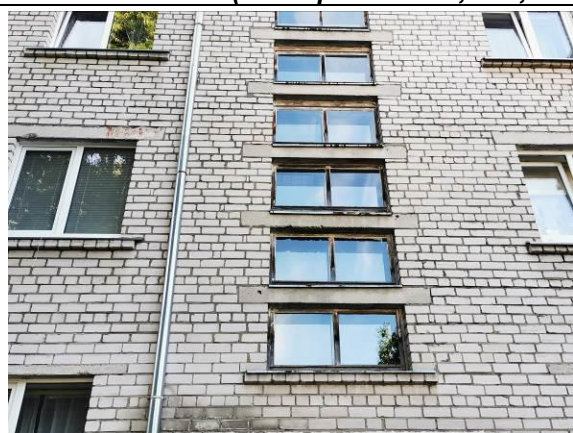
13.att. Logu ailu dz/betona pārsedzes
