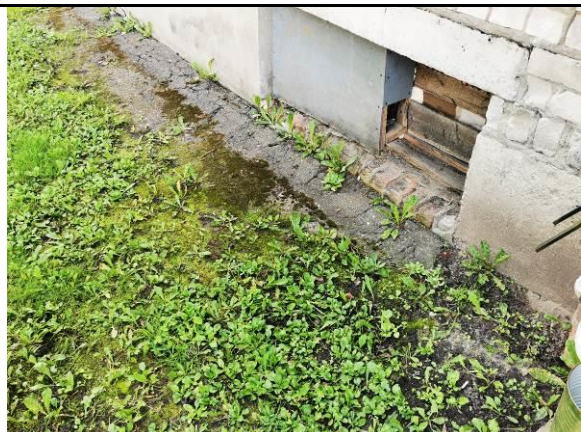
9.att. Nosēdusies betona apmale
