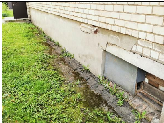
10.att. Nosēdusies betona apmale
