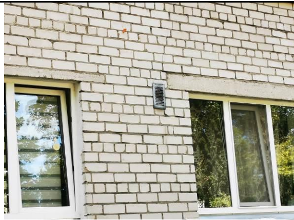
15.att. Logu aiļu dz/betona pārsedze
