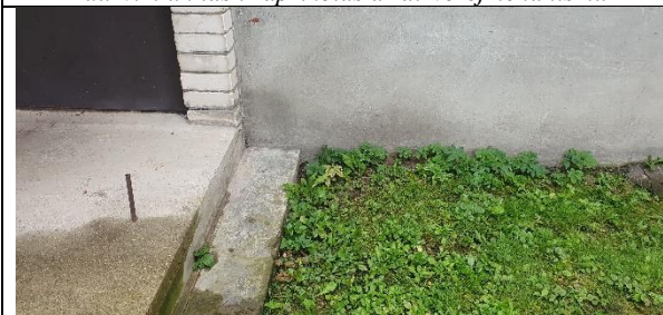
5.att. Nepieciešams veikt pamatu apmales remontu, lai nodrošinātu efektīvu lietuss ūdens novadīšanas sistēmas darbību un nepieļautu ūdens uzkrāšanos un mitruma iesūkšanos pamatos
