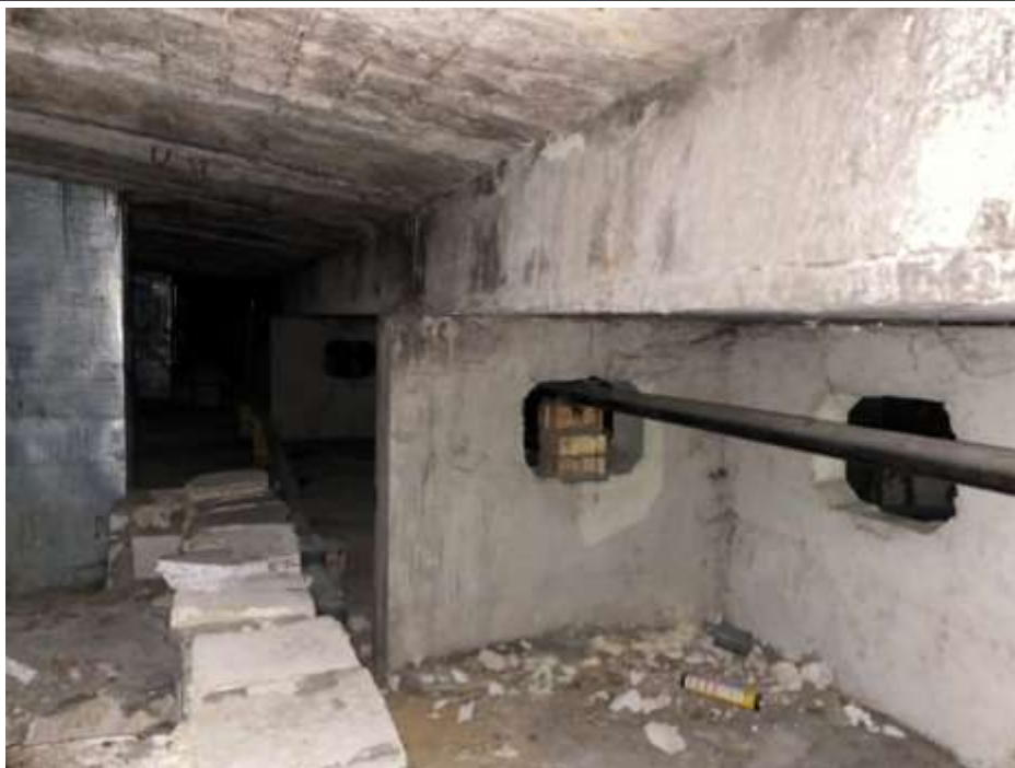
4.8.1.att. Jumta ribotais panelis- nesošais elements – lokāli ūdens notecējumi, balsta vietās nepieciešami šuvju atjaunošana.
