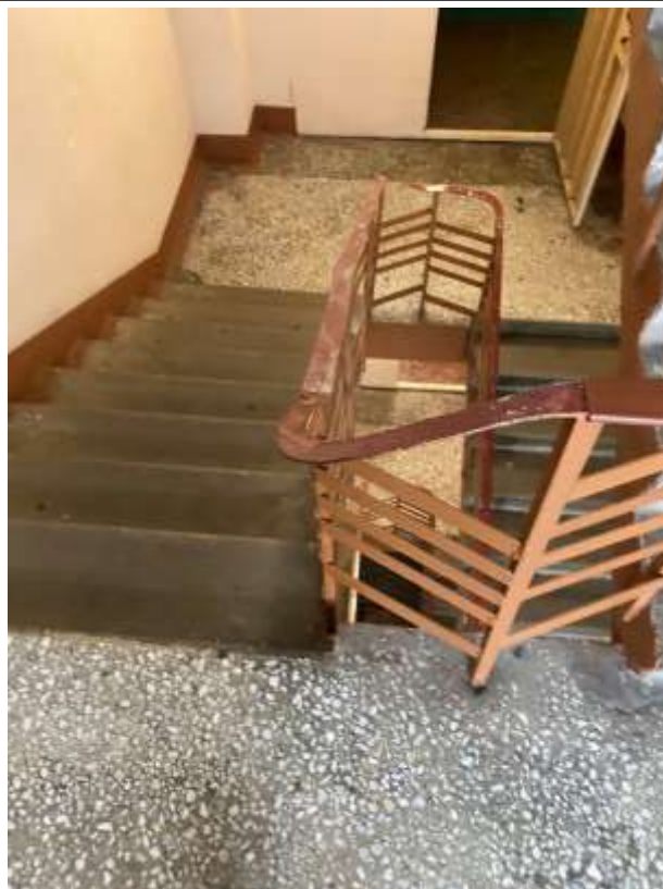
4.10.1.att. Dzelzsbetona konstrukciju starpstāvu kāpnes
