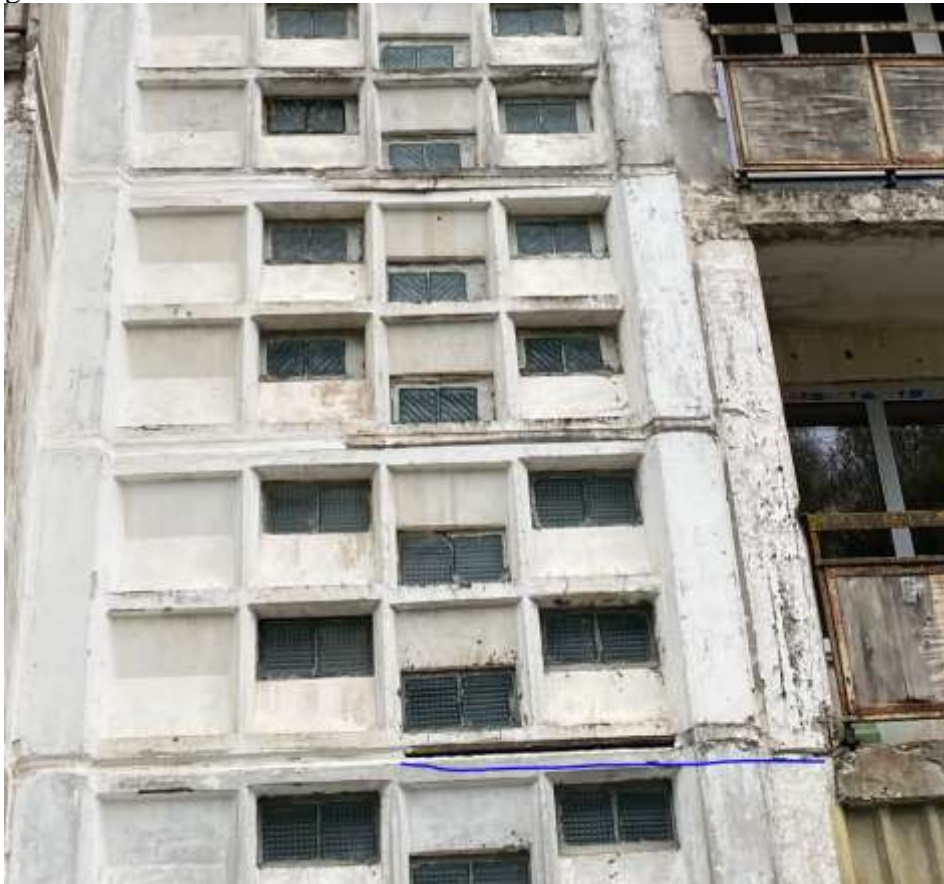
4.5.1.att. Faktiski vertikālajām un horizontālajām šuvēm virs neoprēna gumijas lentes konstatēts aizpildījums ar pakulām un cementa javu vai poroizols un aizpildījums ar cementa javu.
