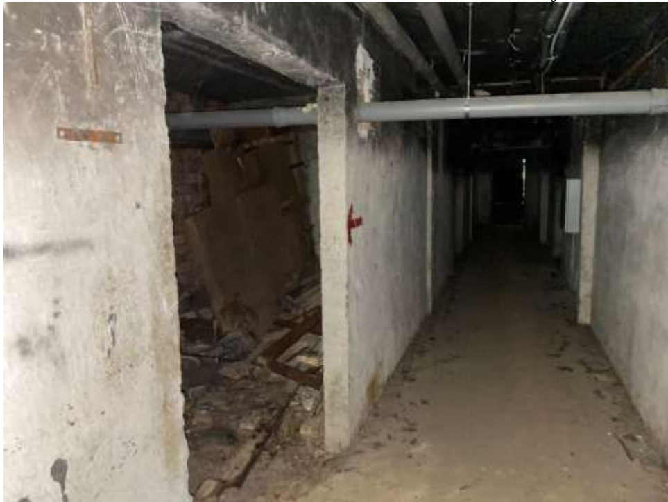
4.1.1. att. Saliekamā dzelzsbetona sienu konstrukcijas
