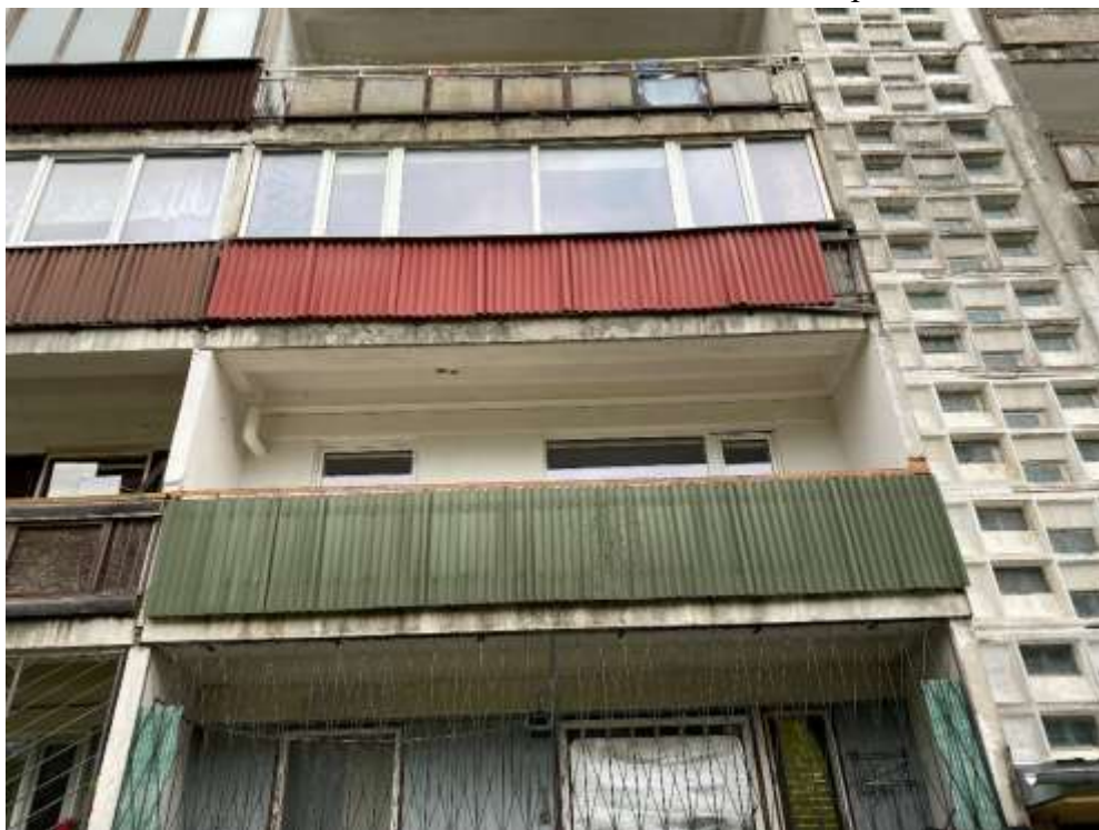
4.2.1.att. Saliekamā dzelzsbetona siena ar lokāliem mitruma pazīmēm uz sienas.
