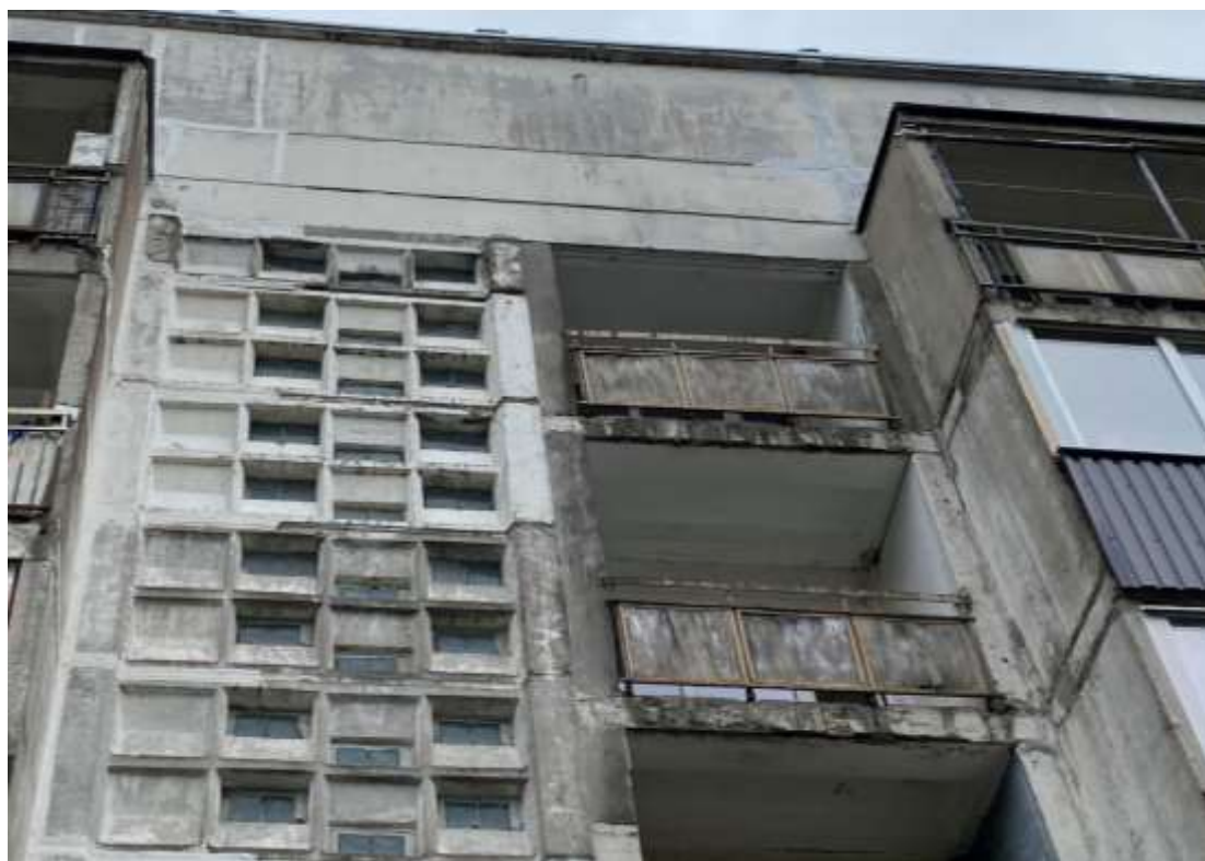
4.2.4.att. Sala, mitruma piesātinājuma bojājumi
