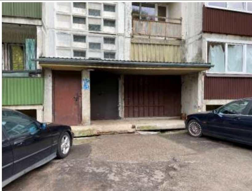
4.2.3.att. Sala, mitruma piesātinājuma bojājumi, bioloģiskais apaugums salaiduma vietā ar vējtvera jumtu
