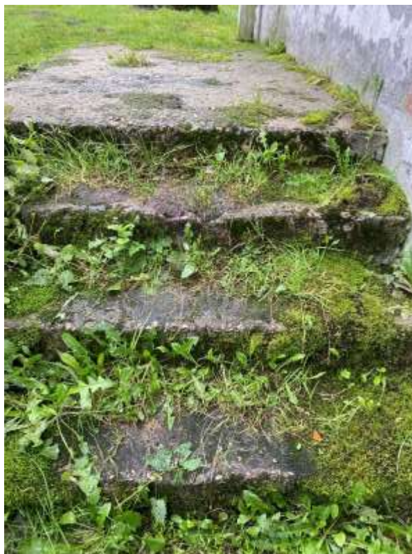
4.10.2.att. Dzelzsbetona konstrukciju pagraba kāpnes ar lokāliem mitruma bojājumiem, veģetatīvo apaugumu.
