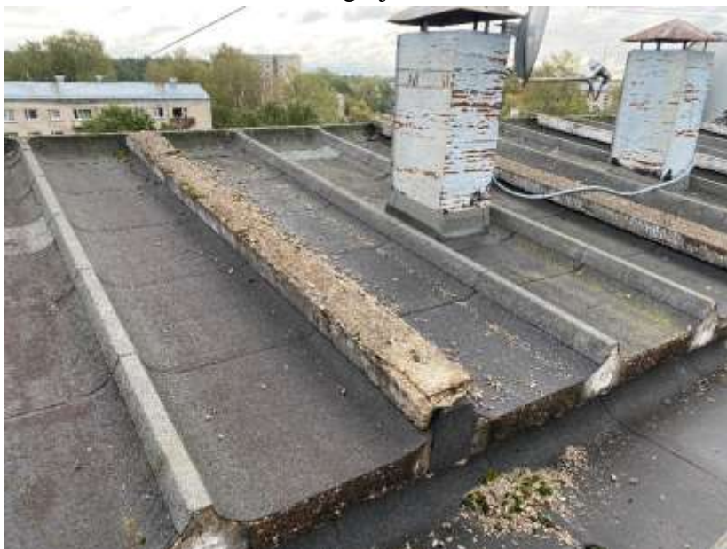
4.8.3.att. Mitruma un sala ietekmē bojāti jumta klāja elementi, atsegts un korodējis stiegorjums
