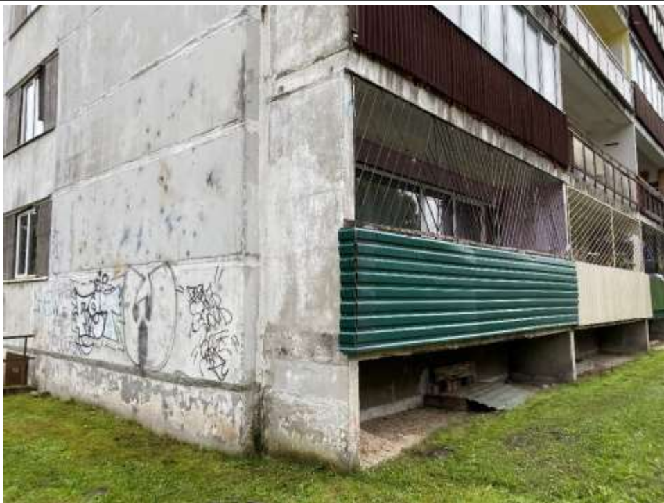
4.2.1.att. Saliekamā dzelzsbetona siena ar lokāliem mitruma pazīmēm uz sienas.
