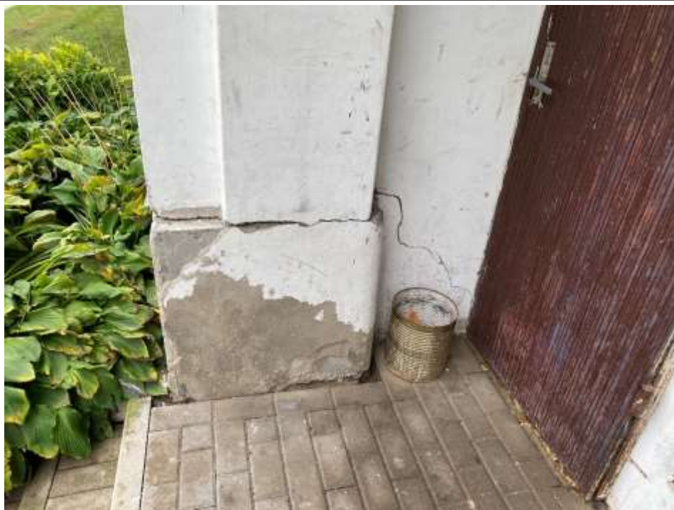
4.9.8.att. Ieejas lieveņa sienai vērojamas plaisas, iespējams no pamatu nevienmērīgas sēšanās
