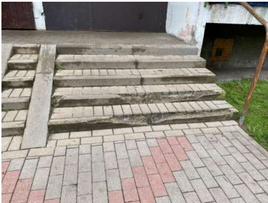
4.10.3.att. Ieejas lieveņa kāpnes ar izdrupumiem
