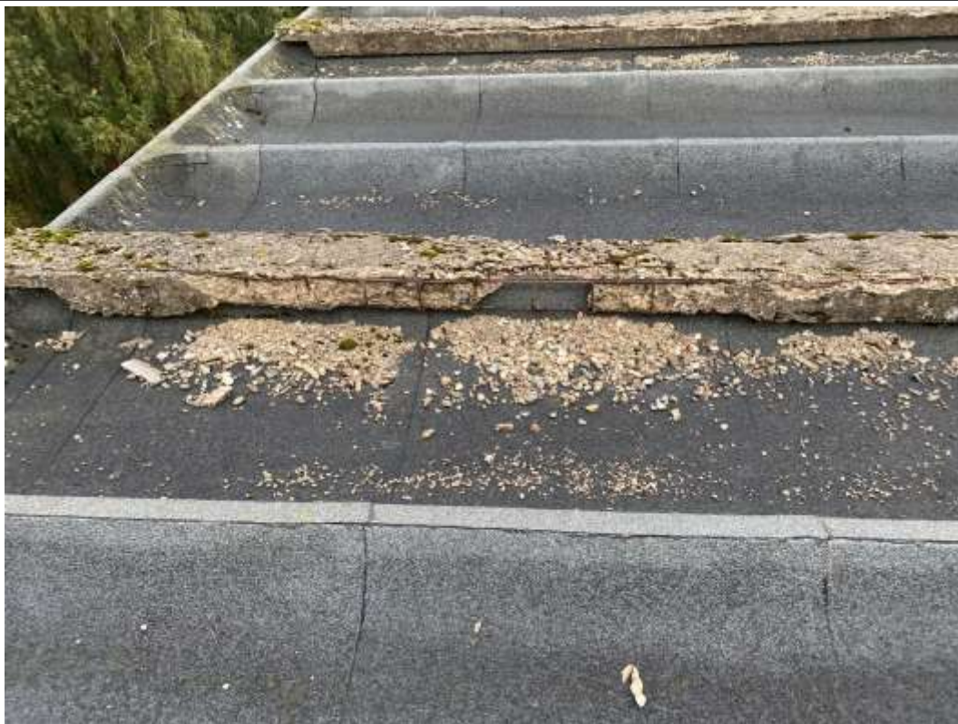
4.8.7.att. Mitruma un sala ietekmē bojāti jumta klāja elementi.
