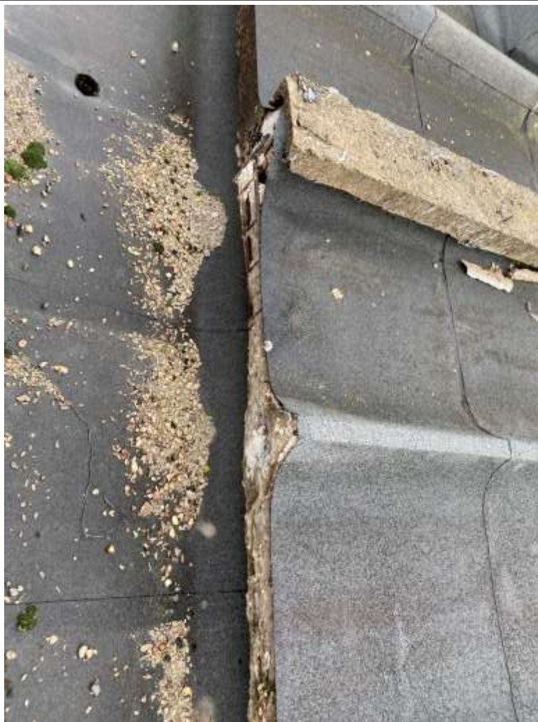
4.8.3.att. Mitruma un sala ietekmē bojāti jumta klāja elementi, atsegts un korodējis stiegorjums
