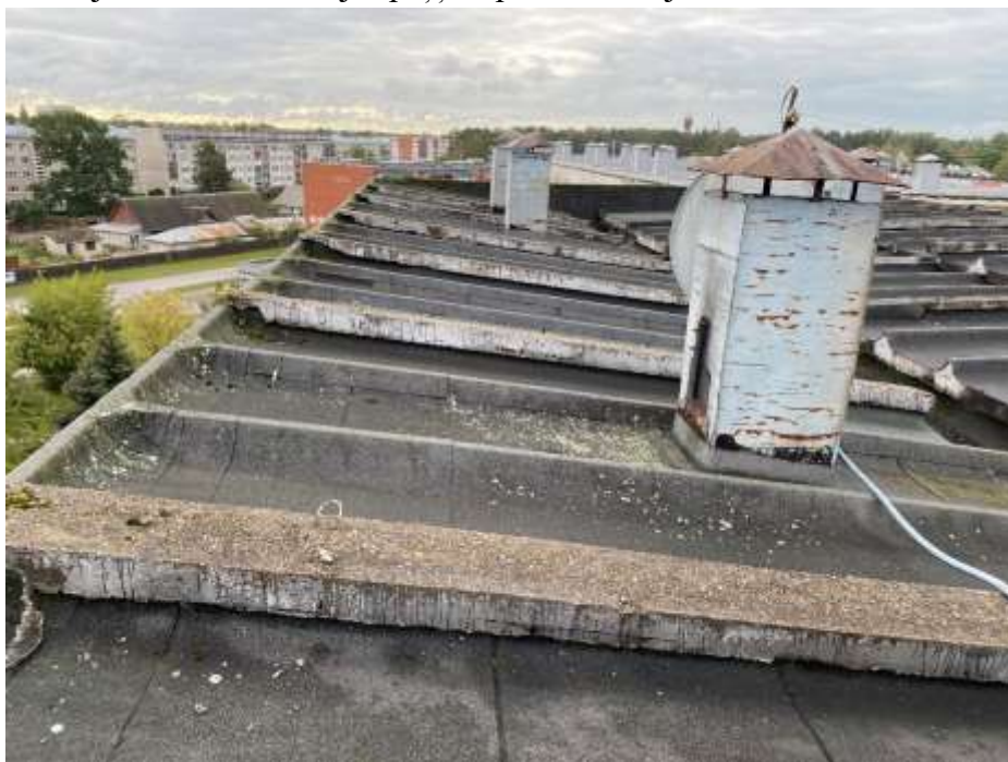
4.8.5.att. Pie jumta lūkas veidojas pelņķes, pie ventilācija izvadiem ir novērots mitrums
