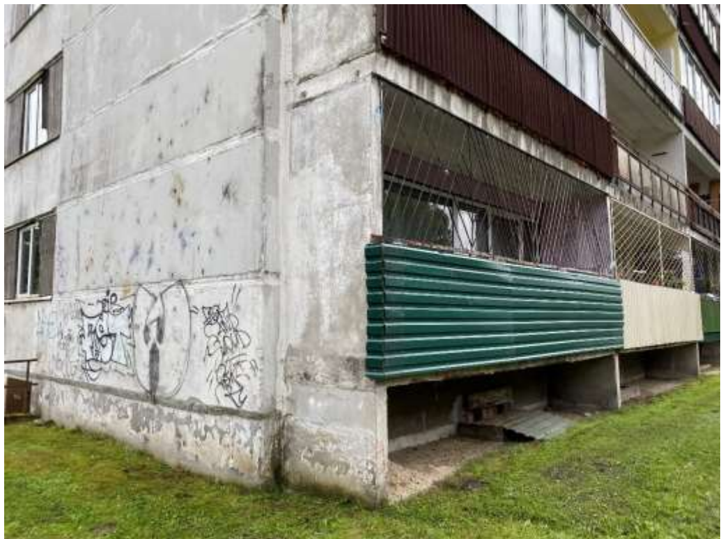
4.1.4. att. Ēkas gala sienām nav izveidotas pamatu apmales uz sienām redzamas mitruma pazīmes.
