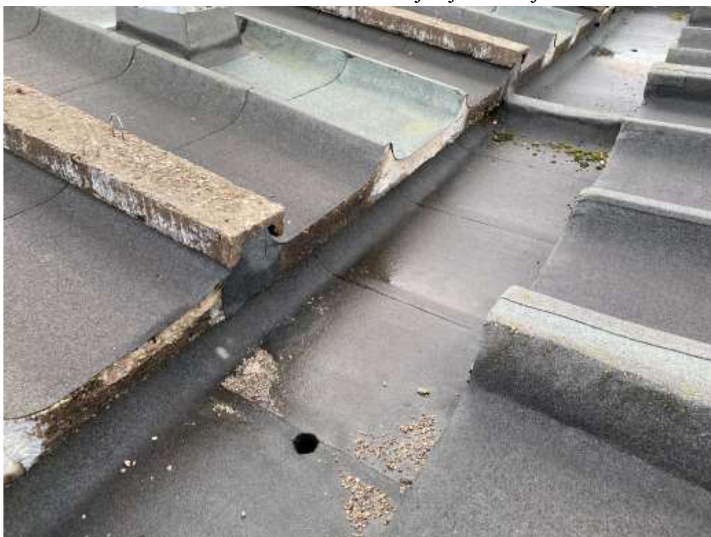
4.8.7.att. Mitruma un sala ietekmē bojāti jumta klāja elementi.
