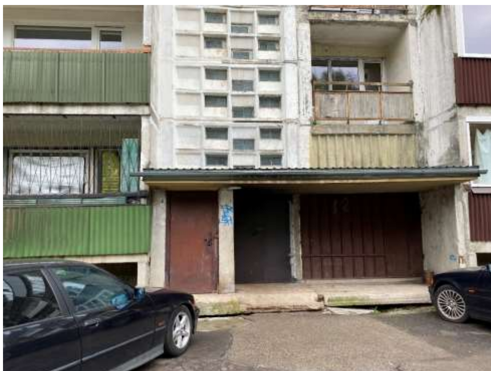
4.9.7.att. Ieejas jumtiņa konstrukcija nepieciešams atjaunot jumta segumu
