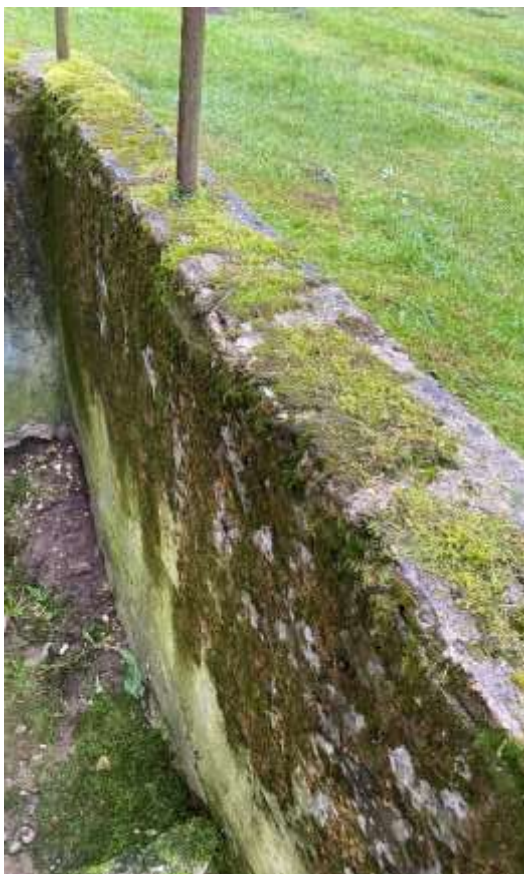
4.1.6. att. Atbalsa siena pie pagārba ieejas durvīm, redzams mitruma pazīmēs
