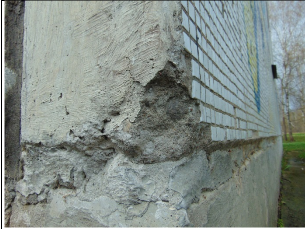
4.att. Veicot ēkas renovāciju, nepieciešams pievērst uzmanību ēkas norobežojošo konstrukciju bojājumu novēršanai un nokrišņu notekūdens aizvadīšanas sistēmas sakārtošanai, lai nepieļautu pārmērīga mitruma nokļūšanu uz ēkas cokola, kā arī ūdens iesūkšanos pamatos.
