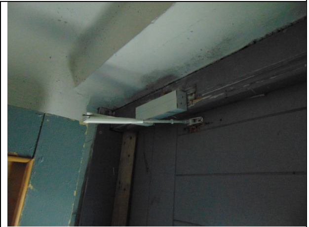
6.att. Lielākajai daļai ēkas ārdurvju uzstādīti aizvērējmehānismi.
