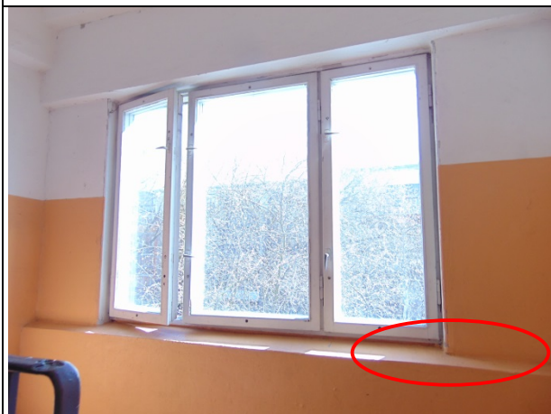
7.att. Tipisks kāpņu telpas koka logs. Attēlā redzama arī ēkas ārsienas biezuma atšķirība starp keramzītbetona paneli (300mm) un tā koka daļu (200mm).
