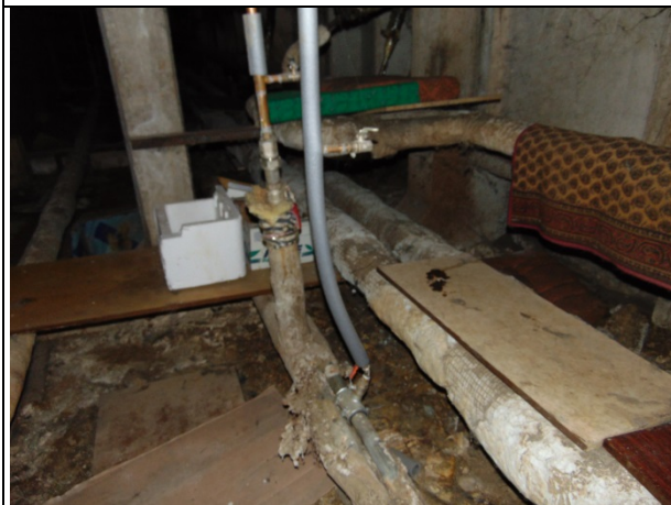
15.att. Ēkā ir veikta daļēja apkures un karstā ūdens stāvvalu nomaiņa, līdz ar to, sistēma strādā nevienmērīgi, nenodrošinot vienādus komforta apstākļus visiem dzīvokļiem.
