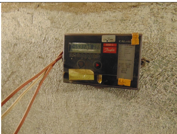
12.att. Siltummezglā uzstādīti divi siltumenerģijas skaitītāji – viens uzskaita kopējo ēkā nodoto siltumenerģijas daudzumu no siltumtīkliem, otrs apkures lokā patērēto siltumenerģiju, taču šis skaitītājs netiek nolasīts. Ieteicams turpmāk veikt apkures loka skaitītāja regulāras apkopes un veikt tā uzrādīto datu nolasīšanu, lai būtu iespējams precīzāk veikt ēkas siltumenerģijas patēriņa datu analīzi un energovadību pēc ēkas renovācijas.
