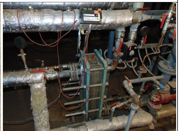
12.att. Siltummezglā uzstādīti divi siltumenerģijas skaitītāji – viens uzskaita kopējo ēkā nodoto siltumenerģijas daudzumu no siltumtīkliem, otrs apkures lokā patērēto siltumenerģiju, taču šis skaitītājs netiek nolasīts. Ieteicams turpmāk veikt apkures loka skaitītāja regulāras apkopes un veikt tā uzrādīto datu nolasīšanu, lai būtu iespējams precīzāk veikt ēkas siltumenerģijas patēriņa datu analīzi un energovadību pēc ēkas renovācijas.
