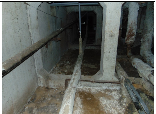
15.att. Ēkā ir veikta daļēja apkures un karstā ūdens stāvvalu nomaiņa, līdz ar to, sistēma strādā nevienmērīgi, nenodrošinot vienādus komforta apstākļus visiem dzīvokļiem.
