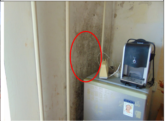
11.att. Atsevišķos gala un 5.stāva dzīvokļos vērojama pelējuma veidošanās, kas liecina par paaugstinātu iekštelpu mitrumu, kā arī nepietiekamu norobežojošo konstrukciju termisko pretestību.
