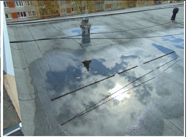
10.att. Uz jumta vērojama nokrišņu ūdens uzkrāšanās. Nepieciešams veikt notekūdens sistēmas sakārtošanu.
