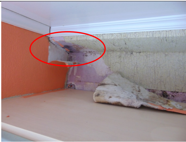
11.att. Atsevišķos gala un 5.stāva dzīvokļos vērojama pelējuma veidošanās, kas liecina par paaugstinātu iekštelpu mitrumu, kā arī nepietiekamu norobežojošo konstrukciju termisko pretestību.
