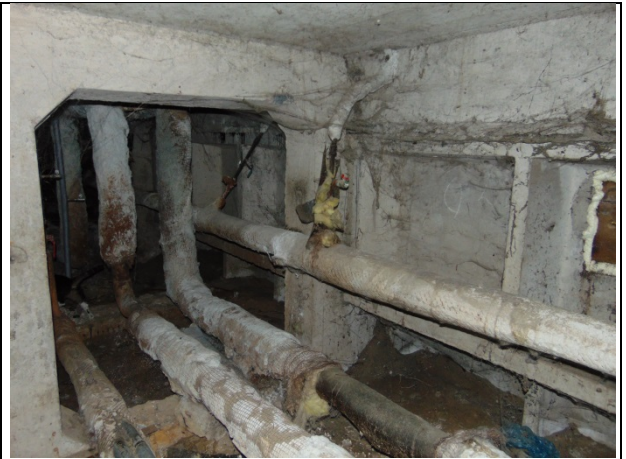
14.att. Veicot apkures sistēmas pārbūvi no viencaurules apkures sistēmas uz divcauruļu apkures sistēmu, ieteicams veikt pilnīgi visu apkures loka cauruļvadu nomaiņu.
