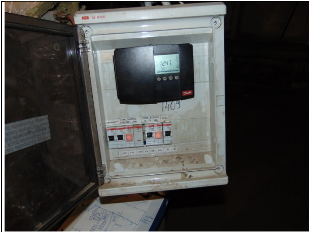
13.att. Siltummezglā iespējams uzstādīt dažādus diennakts apkures režīmus.
