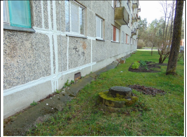
4.att. Veicot ēkas renovāciju, nepieciešams pievērst uzmanību ēkas norobežojošo konstrukciju bojājumu novēršanai un nokrišņu notekūdens aizvadīšanas sistēmas sakārtošanai, lai nepieļautu pārmērīga mitruma nokļūšanu uz ēkas cokola, kā arī ūdens iesūkšanos pamatos.
